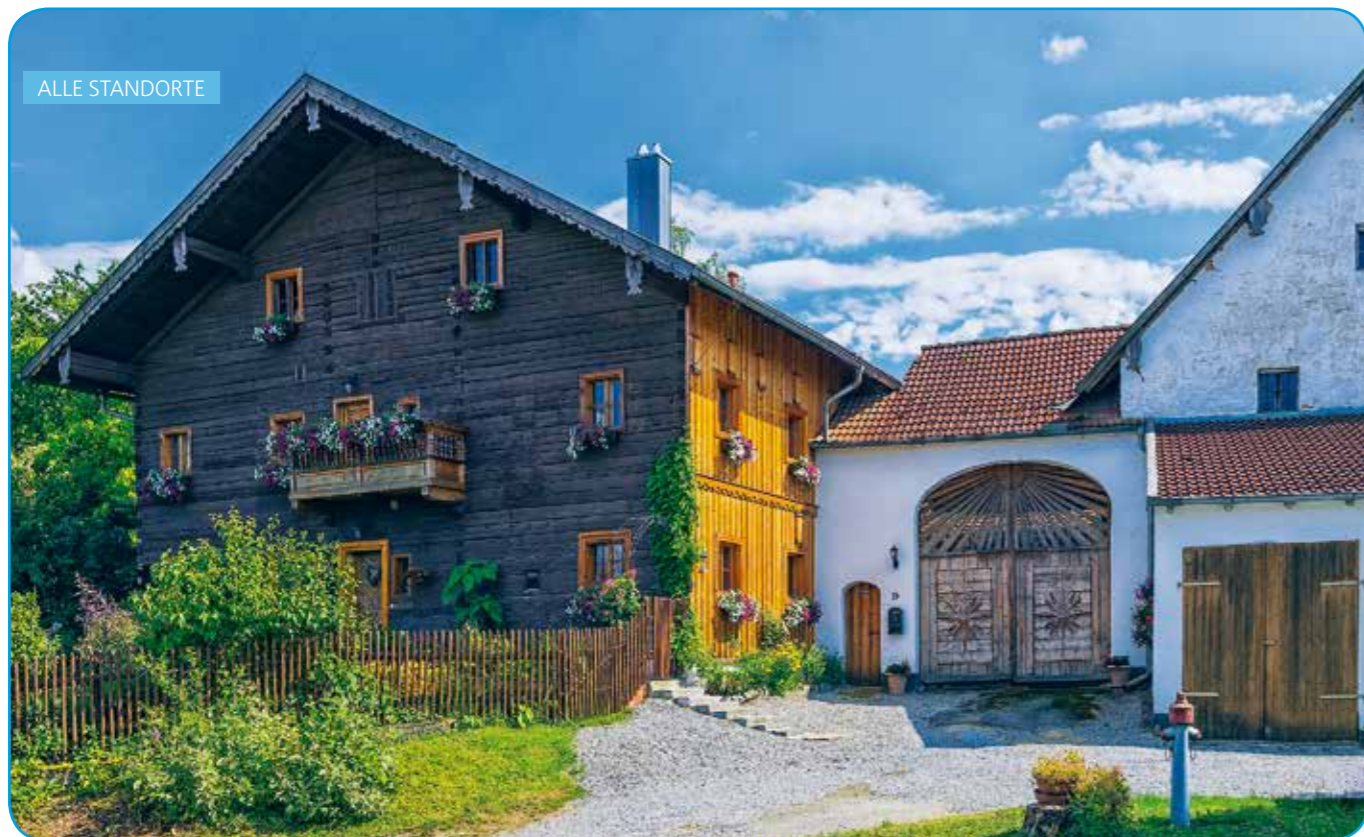
In mühevoller Kleinarbeit hat Marianne Hindinger den elterlichen Hof saniert. Heute strahlt das Anwesen in Algerting wieder in neuem Glanz.
